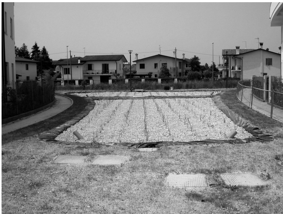
FIGURA 20 – SISTEMI DI FITODEPURAZIONE (ANCORA NON VEGETATI) DI PREGANZIOL
